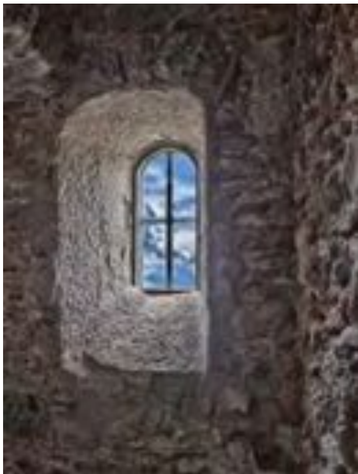
Particolare: finestra di una cella carceraria
